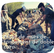
Reparació i construcció de marges i bancals.
