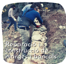
Alçat de murs de tancament de doble pedra.
